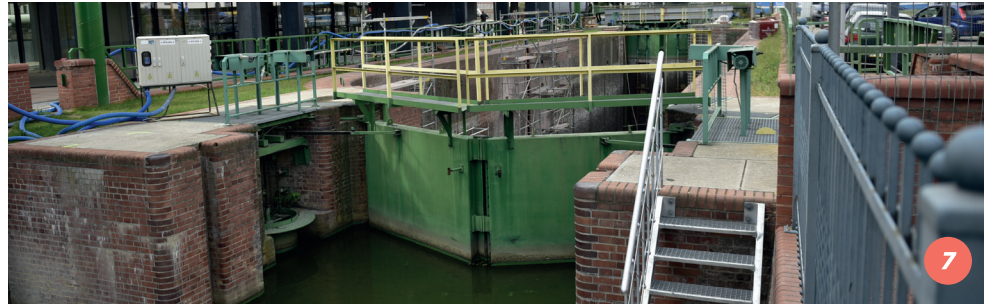
Śluza mieszczarska / Mieszczńska Sluice
