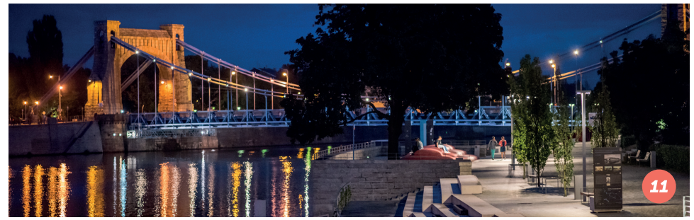
Most Grunwaldzki / Grunwaldzki Bridge
